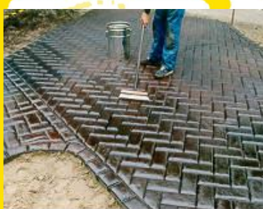
Lusterseal aanbrengen
